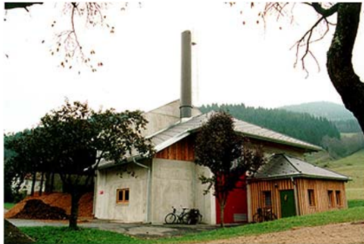
Bereits das vierte Biomasseheizwerk: für ein ganzes Klimabündnistal
